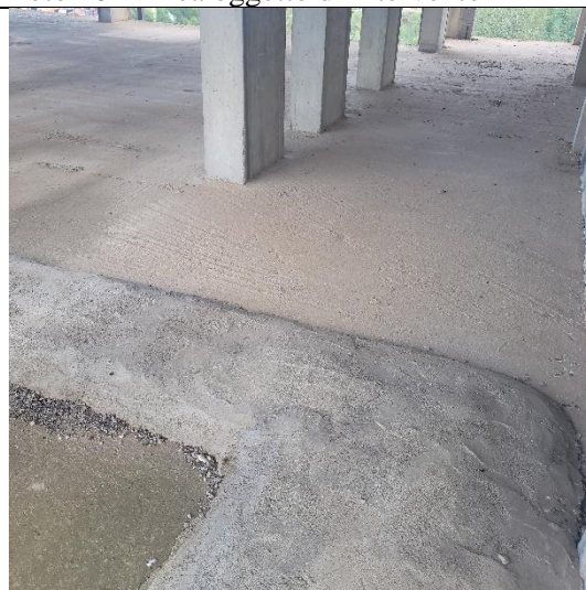
Foto 12 - Tubatura interrata
